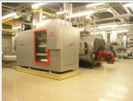
Energetische Optimierung der Produktions- und Verwaltungsgebäude der Procter & Gamble Manufacturing GmbH am Standort Crailsheim
